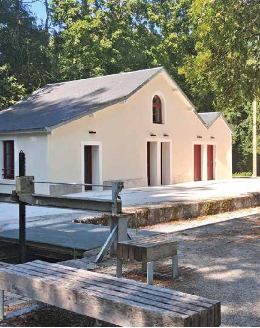
Réhabilitation complète de la Maison éclusière de Reussy, à Mehun-sur-Yèvre.
